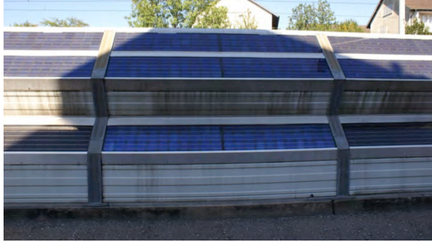
Abb. 5: Verschattung durch nahestehendes Haus
