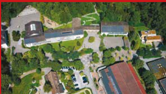
Partizipieren Sie an einem innovativen Stromnetzwerk: Die Zürichsee Solarstrom AG baut und betreibt Anlagen auf «fremden» Gebäuden, so zum Beispiel auf den Schulgebäuden und der Turnhalle in Erlenbach. Leistung insgesamt 193 kWp.
