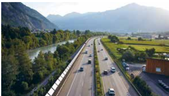
Profitieren Sie von über 30 Jahren Erfahrung: TNC hat 1989 die weltweit erste PV-Schallschutzwand entlang der A13 konzipiert, gebaut und messtechnisch begleitet. Die Anlage ist heute immer noch in Betrieb. Leistung 100 kWp.
