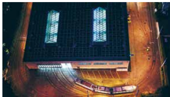
Vertrauen Sie uns bei Grossprojekten: TNC meistert komplexe Aufgabestellungen — so zum Beispiel die Realisierung der PV-Anlage auf dem Tramdepot Irchel der Verkehrsbetriebe der Stadt Zürich (VBZ). Leistung 224 kWp.
