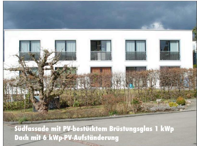
**Südfassade mit PV-bestücktem Brüstungsglas 1 kWp
